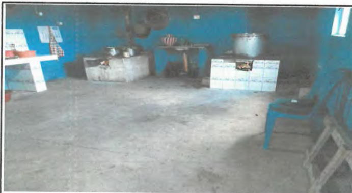
Foto 3: instalación de piso cerámico de 33 metros cuadrados
