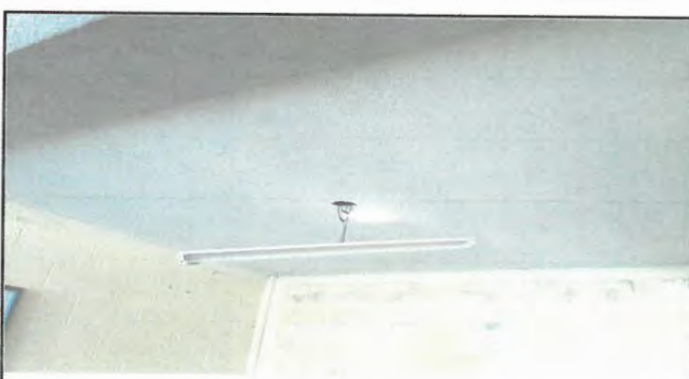
Foto 4: Sustitución de plafoneras.
