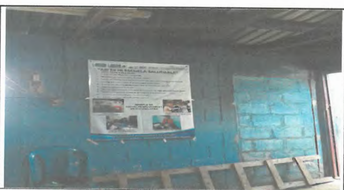
Foto 6: Reparación de cableado eléctrico.
