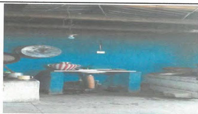
Foto 4: Sustitución de pila de cementó de dos lavaderos.
