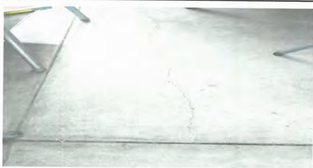
Foto 3: Implementación de piso cerámico (aula 2)
