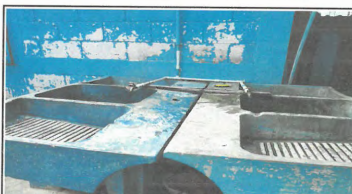
Foto 4: Sustitución de llaves de chorro.
