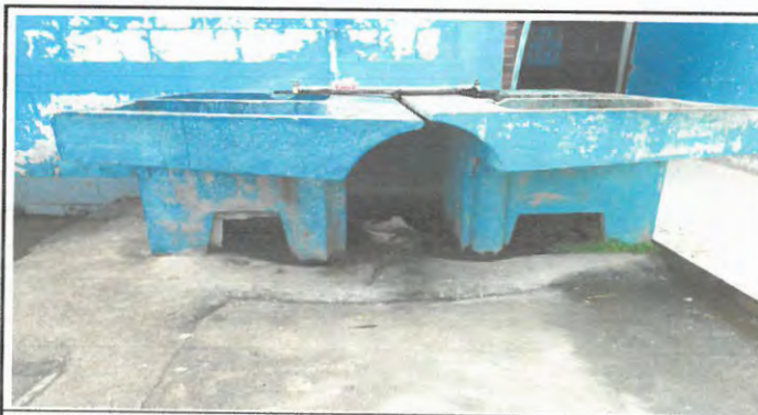
Foto 6: Mejoramiento de pila.
