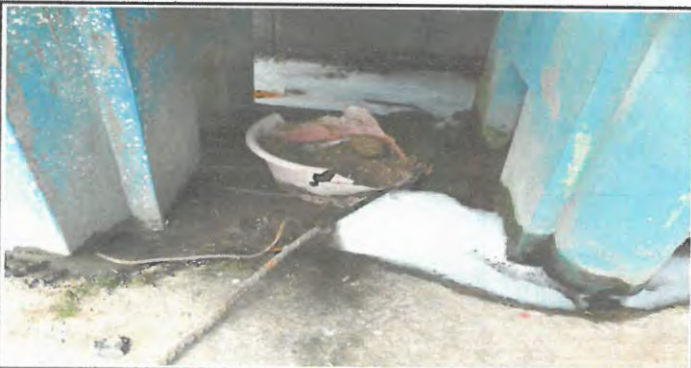
Foto 5: Reparación de piso de torta de concreto.
