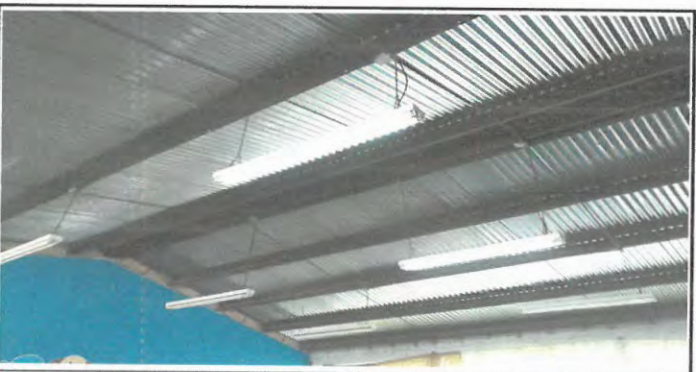
Foto 5: Reparación de lámparas.
