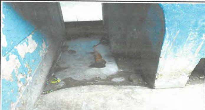
Foto 1: Mantenimiento de reposaderas.
