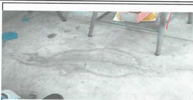
Foto 2: Implementación de piso cerámico (aula 1)
