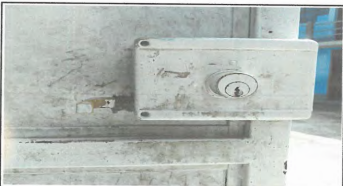
Foto 3: Sustitución de 2 chapas de puertas para aulas.
