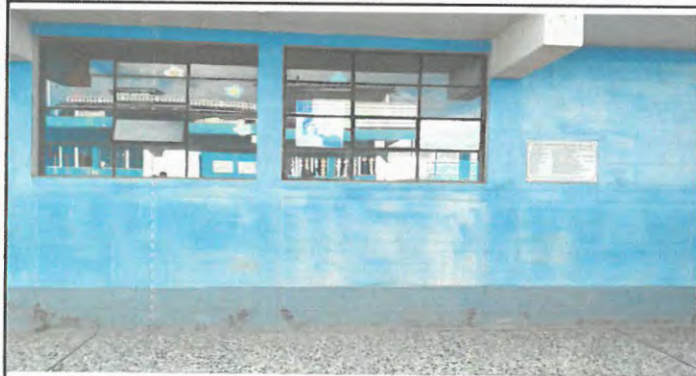
Foto1: Pintura en muros exteriores e interiores (aulas)
