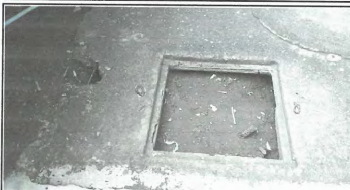
Foto 2: Mantenimiento de cajas de registro.
